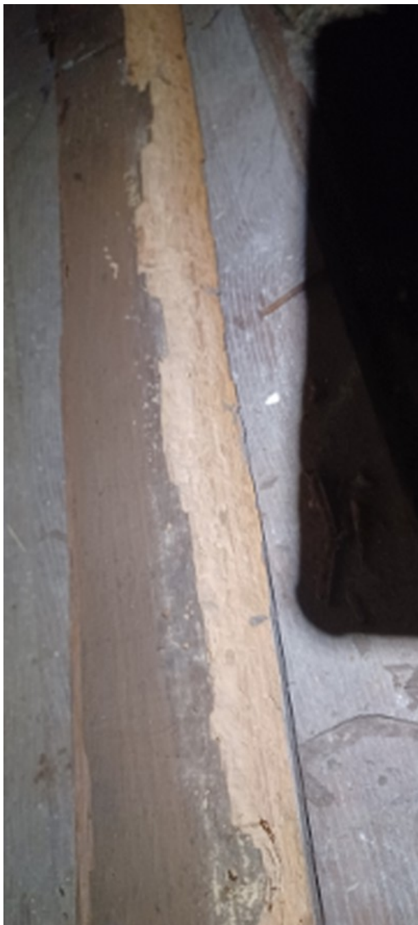
Maison / Rez-de-jardin / Salon 1 / Zone A / Plancher [grosse vrillette] [Prélèvement n°1]
